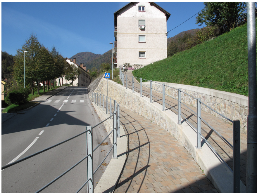
Slika 2: Obnovljena cesta z novimi površinami za pešce in invalide.
